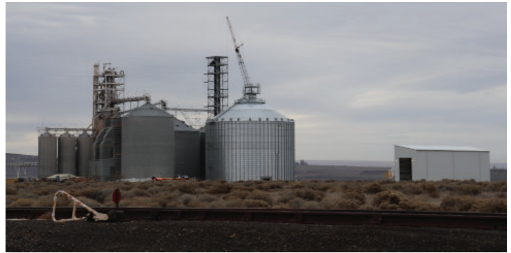
Una nueva instalación de descarga de alta velocidad está en construcción en la terminal granera en Boardman.
