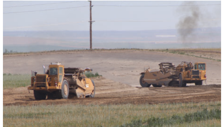
Los motores de la Tierra preparan la nueva plataforma de ferrocarril en el Parque Industrial East Beach.
