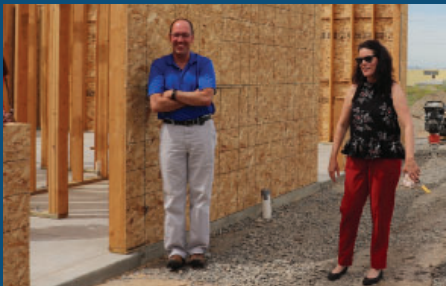
Maureen McGrath y Dan Daltoso de UMCHS recorren el sitio de construcción.
