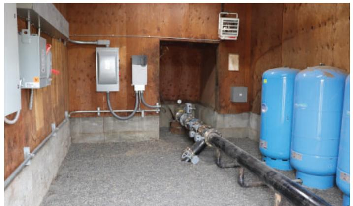
*El pozo del parque industrial del Sur de Morrow en Heppner se actualizó recientemente con un VFD y PLC.*
